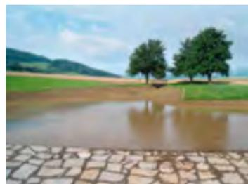
Vorteile der Erdbauweise sind die geringeren Baukosten und die mögliche naturnahe Gestaltung. Vorteil der Betonbauweise ist der geringere Platzbedarf; das Becken kann auch unterirdisch errichtet werden. Regenrückhaltebecken besitzen meist ein Nutzvolumen von 150–250 Kubikmeter je angeschlossenem Hektar befestigter Fläche, je nach örtlichen Verhältnissen aber auch mehr oder weniger.
